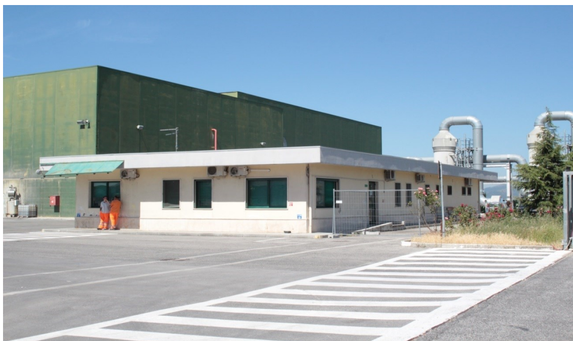
Impianto S.T.I.R. di Casalduni (Bn)
